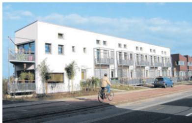
De passiefhuizen van architect Erik Franke aan de Rivierdijk in Sliedrecht. FOTO FRANKE ARCHITECTEN
