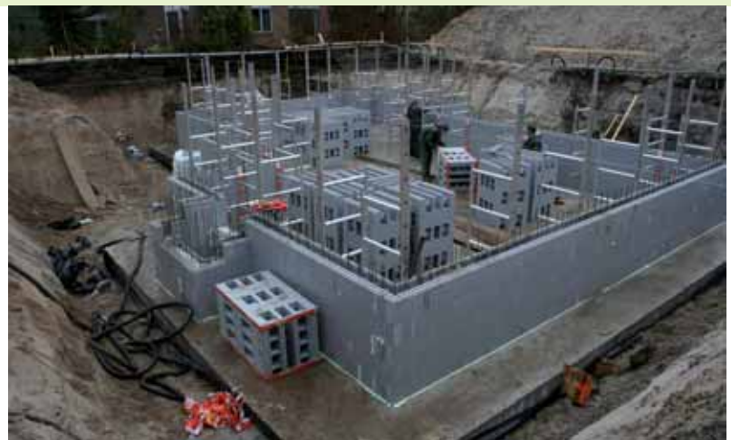
Isorast bouwelementen van eps laten zich bijna net zo gemakkelijk stapelen als lego. Als de wanden zijn opgebouwd, wordt de binnenkern volgestort met beton.
